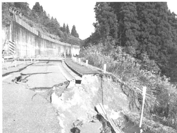
図 2 十日町から川口に向かう道路：震災後も日ごとに谷側に向かって崩れ続けている。
