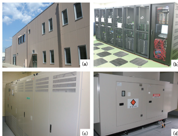
図3 次期システムに向けてのインフラ整備
